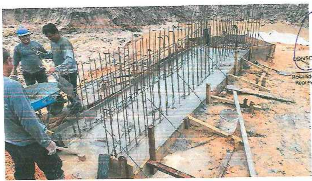
SE APRECIA VACIO DE MORTERO EN PROGRESIVA 1+564 Foto N° 14 ING° RAUL PINEDA RODRIGUEZ RESIDENTE DE OBRA CIP N° 31118
