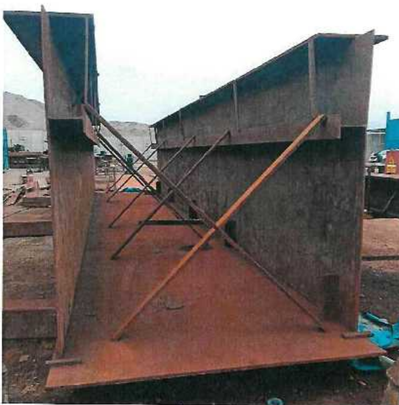
FOTOGRAFÍA N°04: FABRICACION DE VIGAS CAJONES TRANSVERSALES
