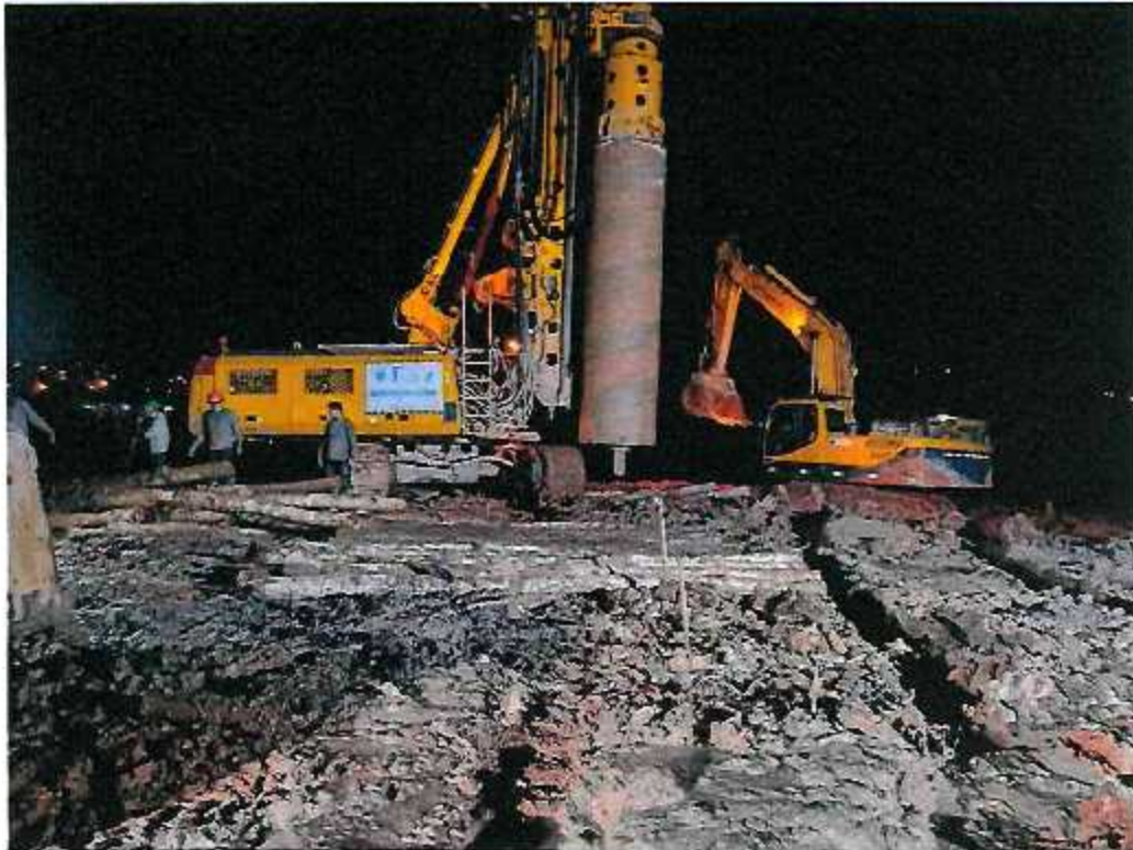
FOTOGRAFÍA N°05: TRABAJOS DE CONTROL DE EXCAVACION EN PILOTES
