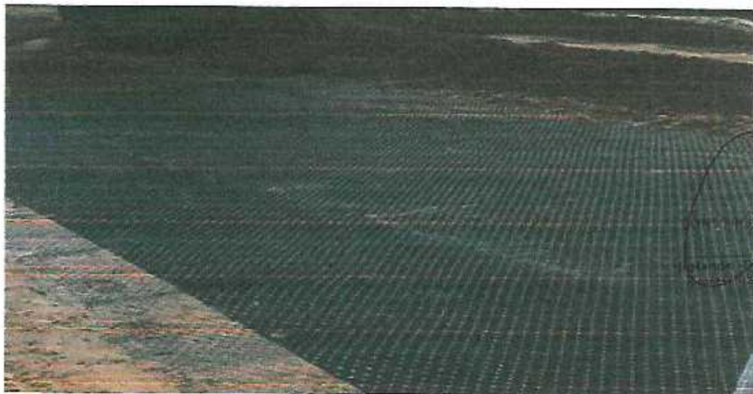
APRECIAMOS TENDIDO DE GEOMALLA Foto N° 09
