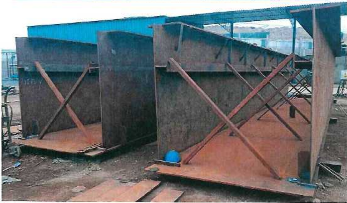
FOTOGRAFÍA N°06: FABRICACIÓN DE VIGAS CAJONES TRANSVERSALES
