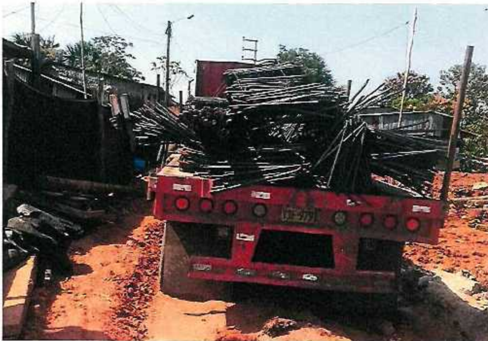
FOTOGRAFÍA N°06: SUMINISTRO Y HABILITADO DE ACERO PARA LOSA
