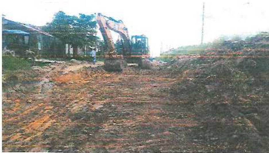
SE APRECIA CORTE DE TERRENO
