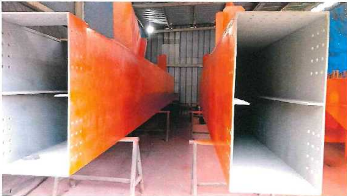
FOTOGRAFÍA N°18: TRABAJOS DE PINTADO DE ESTRUCTURAS METALICAS DEL PUENTE
