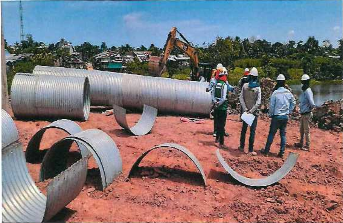
FOTOGRAFÍA N°13: TRABAJOS DE ARMADO DE ALCANTARRILLAS METALICAS
