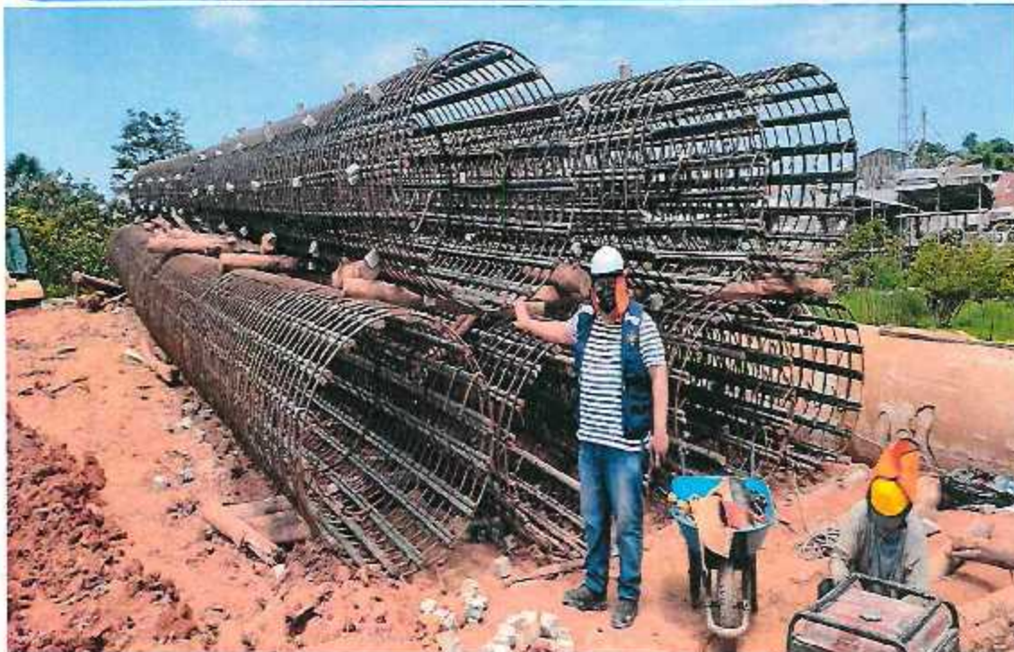
FOTOGRAFÍA N°09: TRABAJOS DE ARMADO DE ACEROS PARA LOS PILOTES Y PILARES
