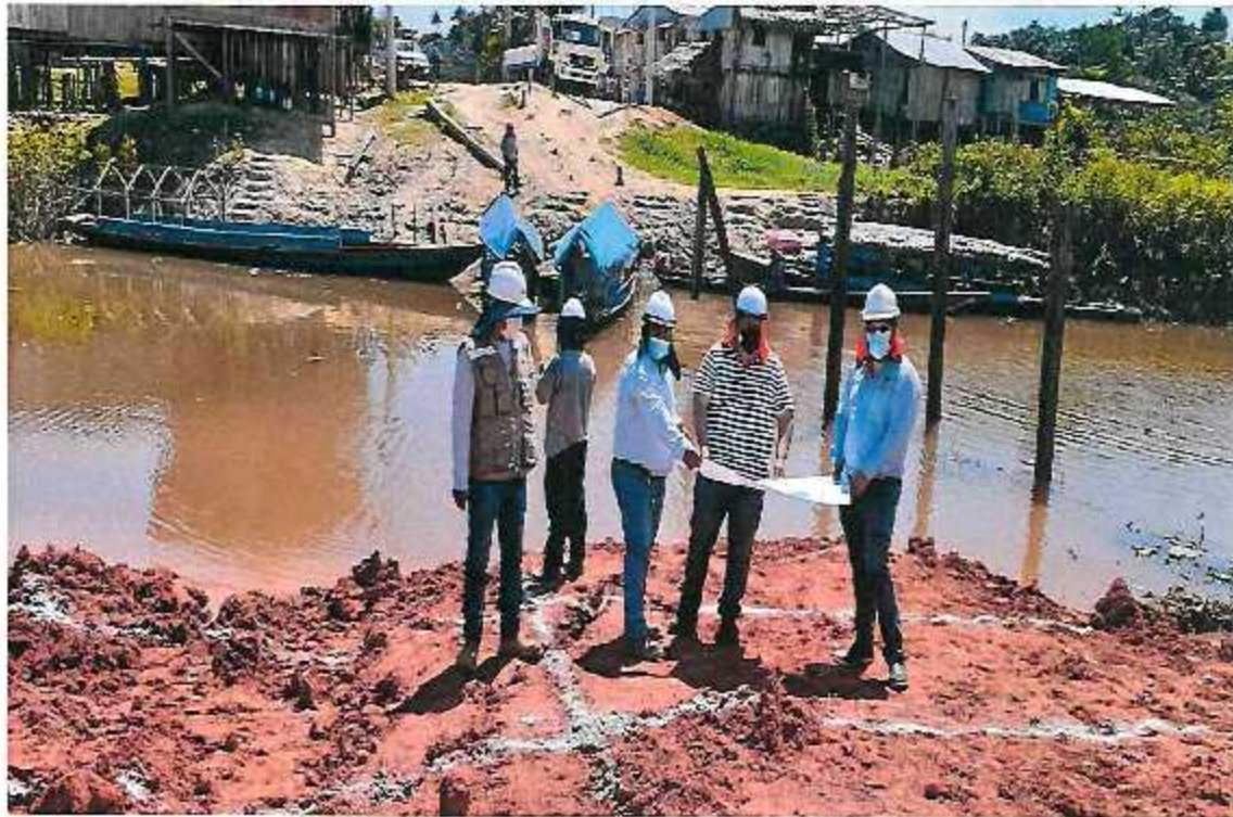
FOTOGRAFÍA N°14: TRABAJOS DE COORDINACIÓN CON EL PERSONAL TECNICO EN OBRA
