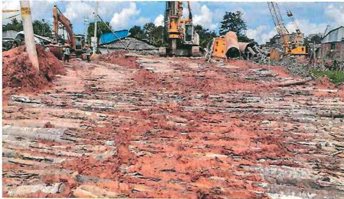
FOTOGRAFÍA N°02: TRABAJOS DE CONFORMACION DE PLATAFORMA
