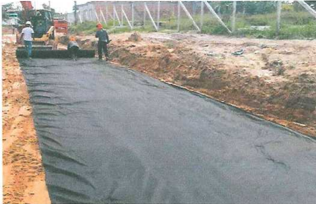
APRECIAMOS TENDIDO DE GEOTEXTIL Foto N° 09
