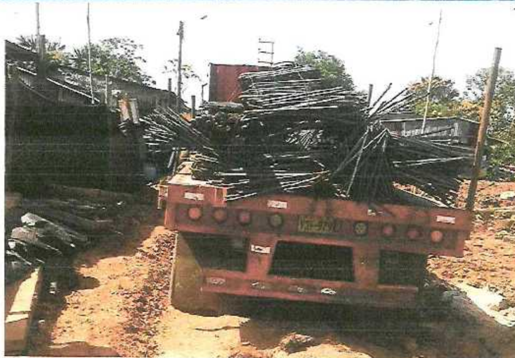
FOTOGRAFÍA N°03: SUMINISTRO Y HABILITADO DE ACERO PARA LOSA
