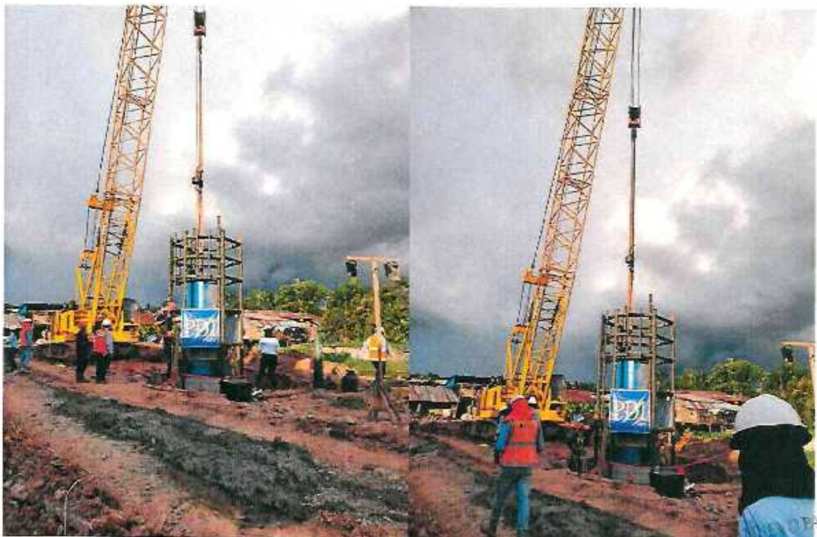
FOTOGRAFÍA N°03: TRABAJOS DE PERFORACION DE PILOTES Y PRUEBAS PDL
