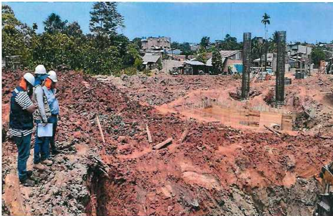
FOTOGRAFÍA N°06: COLOCACION DE ACEROS PARA REALIZAR EN ELCONFRADO EN PILOTES
