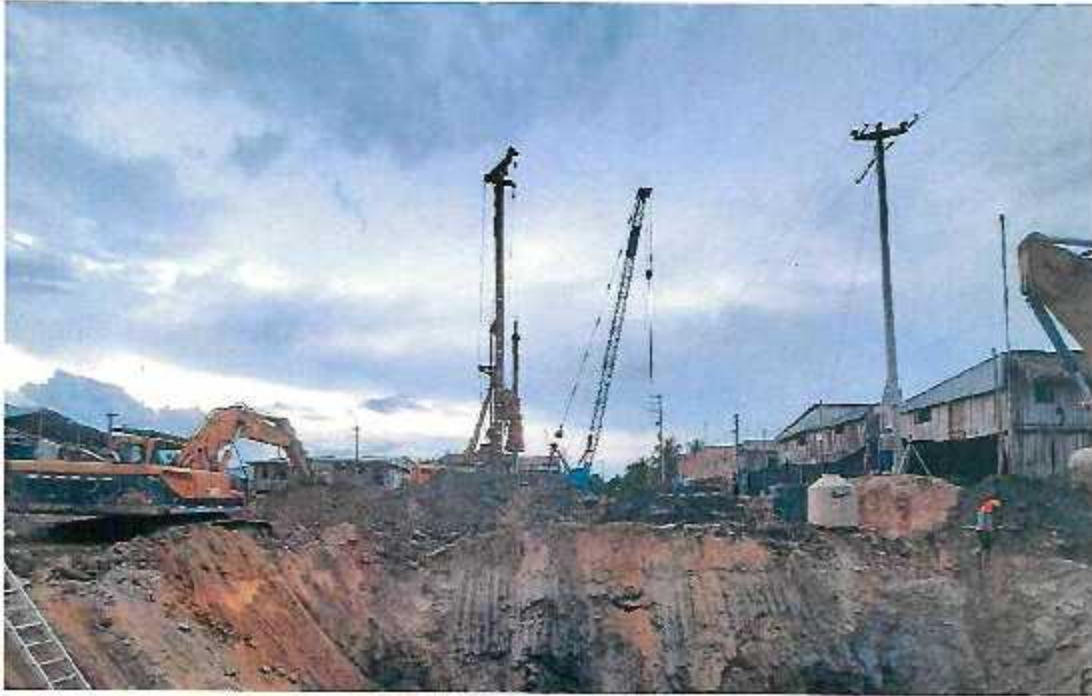
FOTOGRAFÍA N°01: TRABAJOS DE EXCAVACIÓN P/ESTRUCTURAS CON MAQUINARIA
