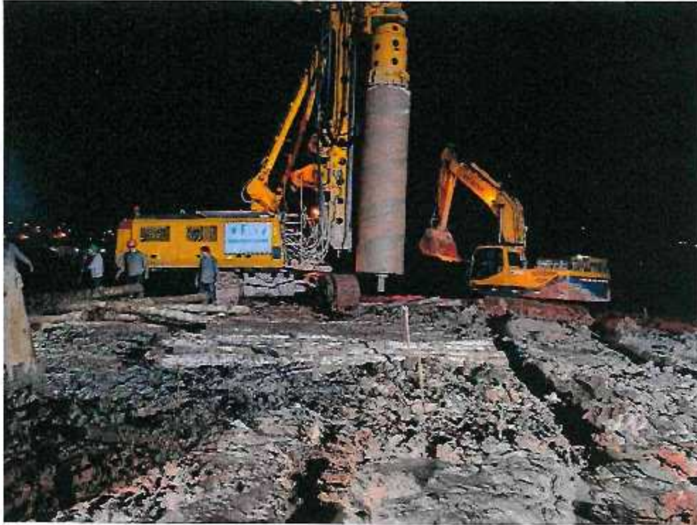
FOTOGRAFÍA N°01: TRABAJOS DE PERFORACION DE PILOTES
