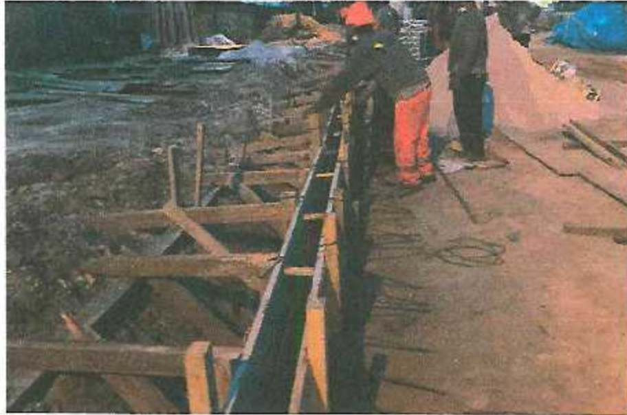
ENCOFRADO Y ENTIBADO DE SARDINELES Foto N° 15
