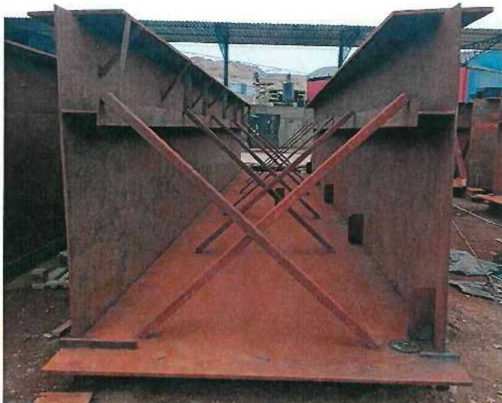
FOTOGRAFÍA N°07: FABRICACIÓN DE VIGAS LONGITUDINALES
