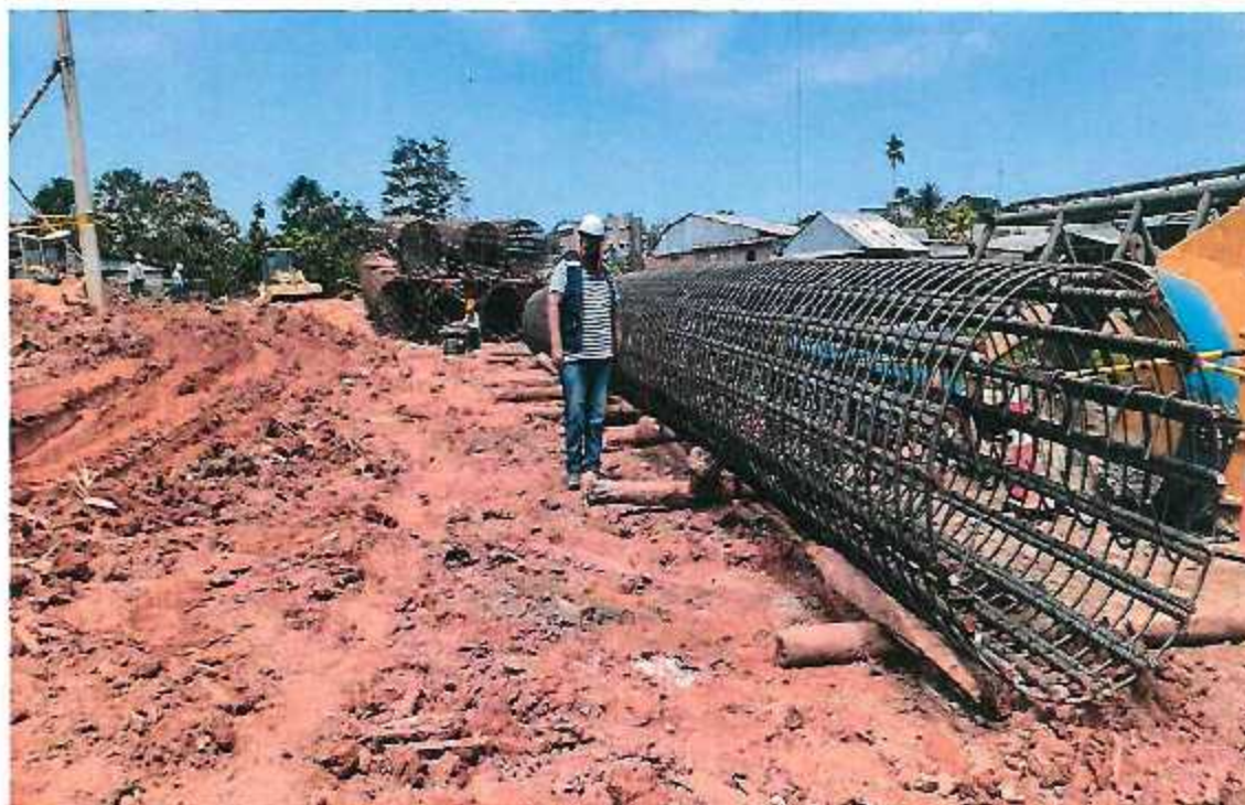
FOTOGRAFÍA N°10: TRABAJOS CULMINADO DEL ARMADO DE ACEROS PARA LOS PILOTES Y PILARES
