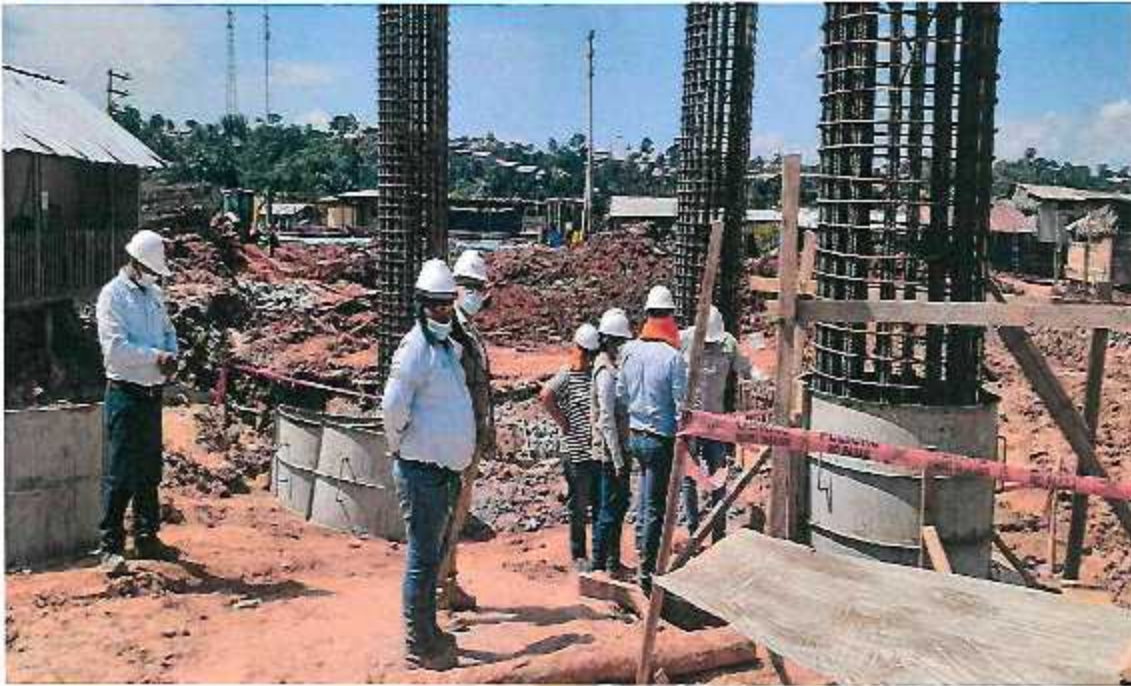
FOTOGRAFÍA N°05: TRABAJOS DE ARMANDO DE ACERO Y VACIADO DE PILOTES
