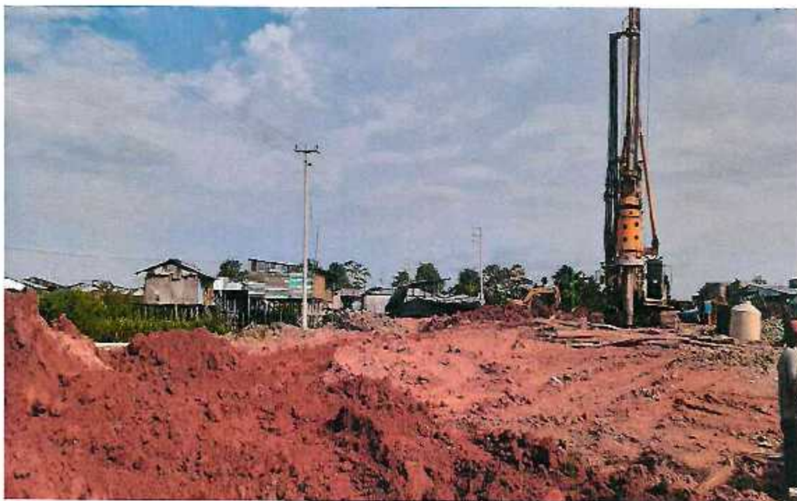
FOTOGRAFÍA N°02: TRABAJOS DE PERFORACION DE PILOTES Y CONTROL DE DIMENSIONES
