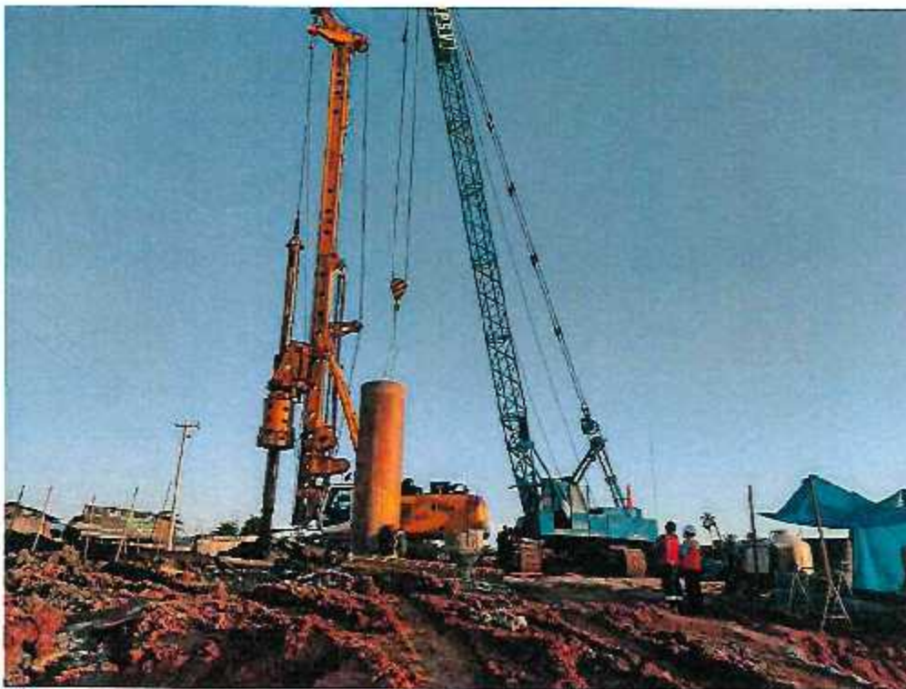
FOTOGRAFÍA N°02: TRABAJOS DE PERFORACION DE PILOTES
