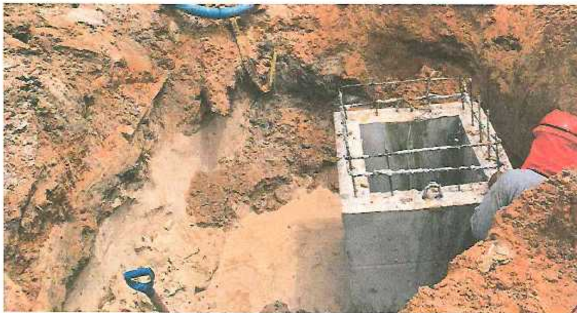
SE APRECIA LA COLOCACION DE CAJA DE INSPECCION DE SUBDREN
