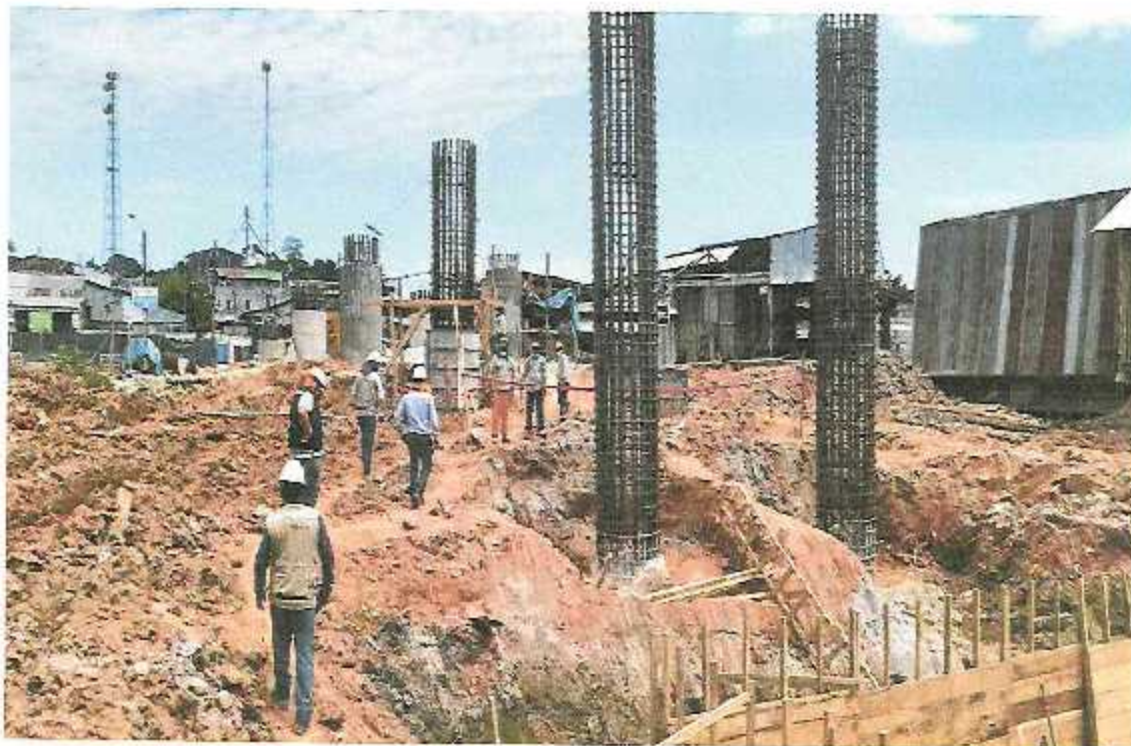
FOTOGRAFÍA N°04: TRABAJOS DE ARMADO DE ACERO Y VACIADO EN PILOTES
