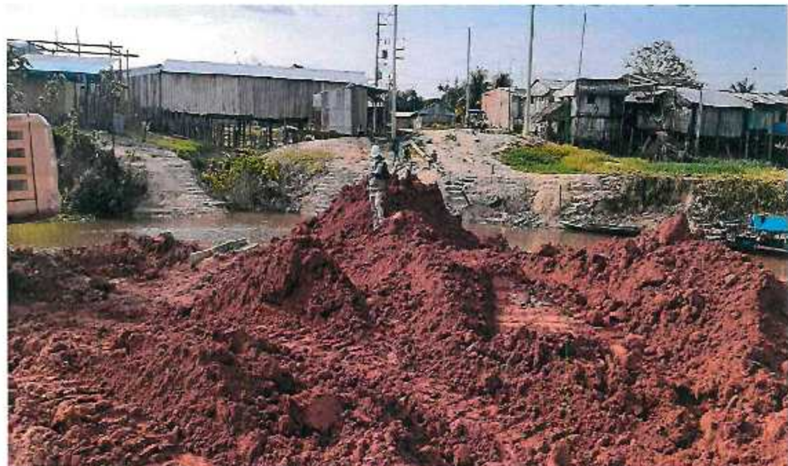
FOTOGRAFÍA N°01: TRABAJOS DE CONFORMACION DE PLATAFORMA
