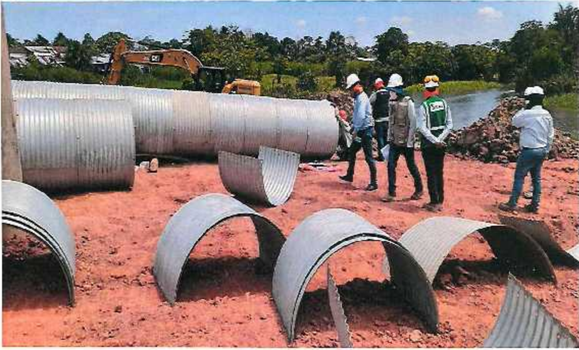
FOTOGRAFÍA N°11: TRABAJOS DE ARMADO DE ALCANTARRILLAS METALICAS
