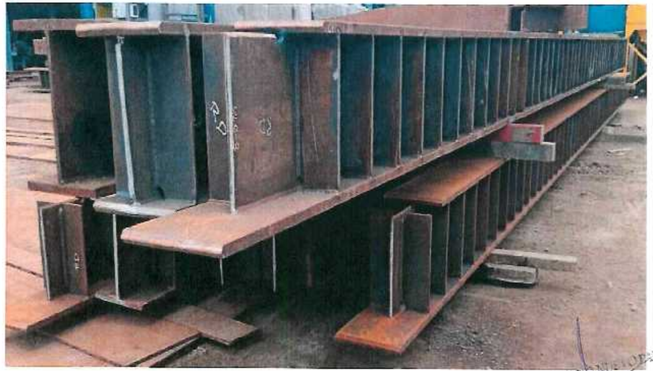
FOTOGRAFÍA N°09: FABRICACIÓN DE VIGAS LONGITUDINALES
