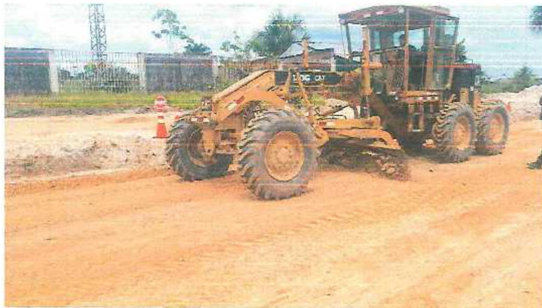
SE APRECIA PERFILADO EN LA CARRETERA
