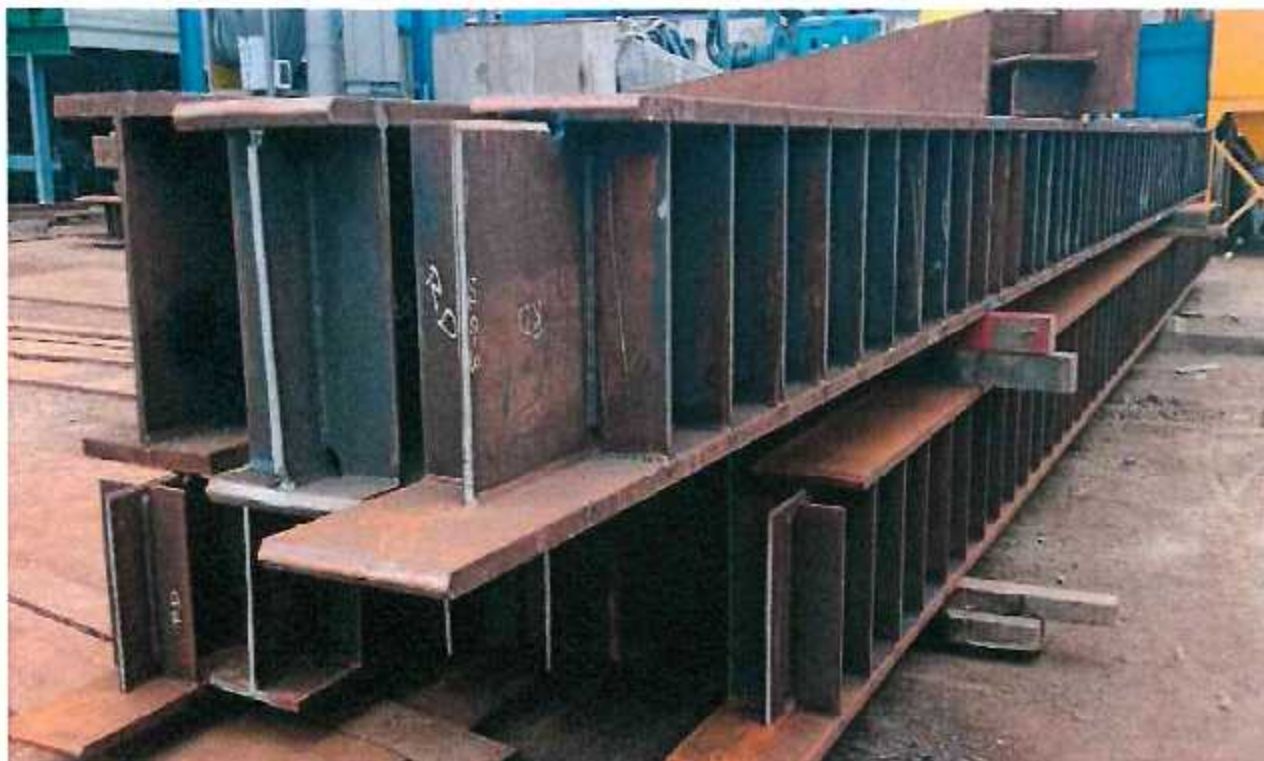
FOTOGRAFÍA N°16: ESTRUCTURA METALICA DEL PUENTE PARA SER PINTADO
