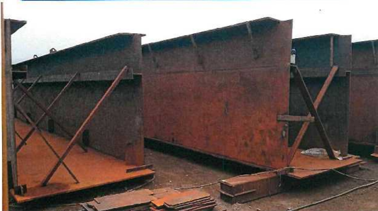
FOTOGRAFÍA N°15: TRABAJOS DE FABRICACION DE ESTRUCTURAS METALICAS, LISTA PARA EL PINTADO
