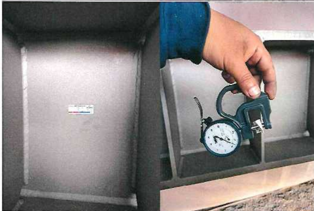
FOTOGRAFÍA N°17: CONTROL DE RUGOSIDAD DEL GRANALLADO DE ESTRUCTURAS METALICAS
