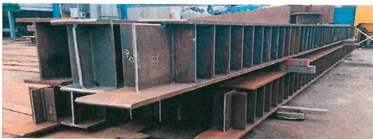
FOTOGRAFÍA N°08: FABRICACIÓN DE VIGAS LONGITUDINALES
