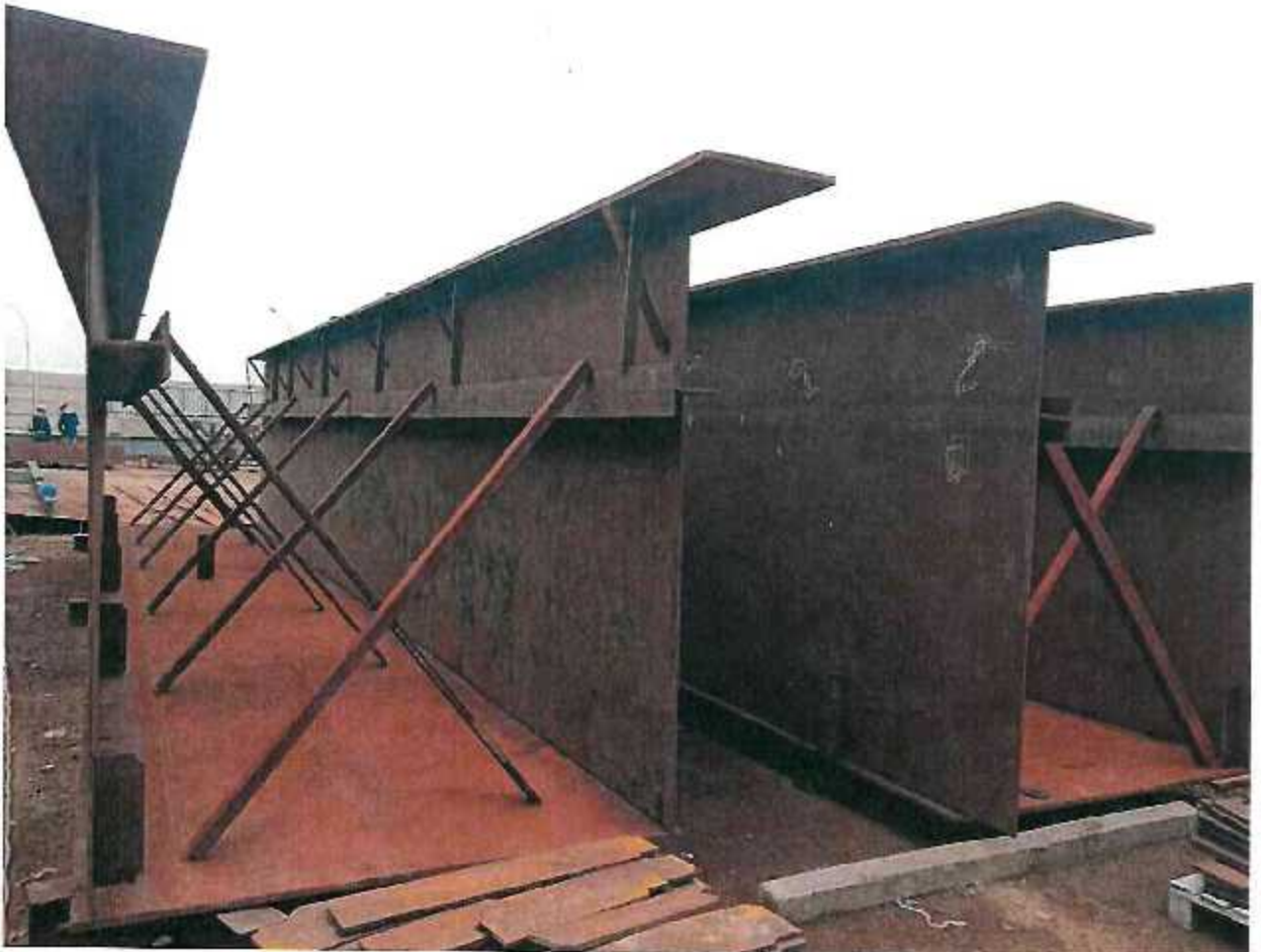
FOTOGRAFÍA N°05: FABRICACIÓN DE VIGAS CAJONES TRANSVERSALES
