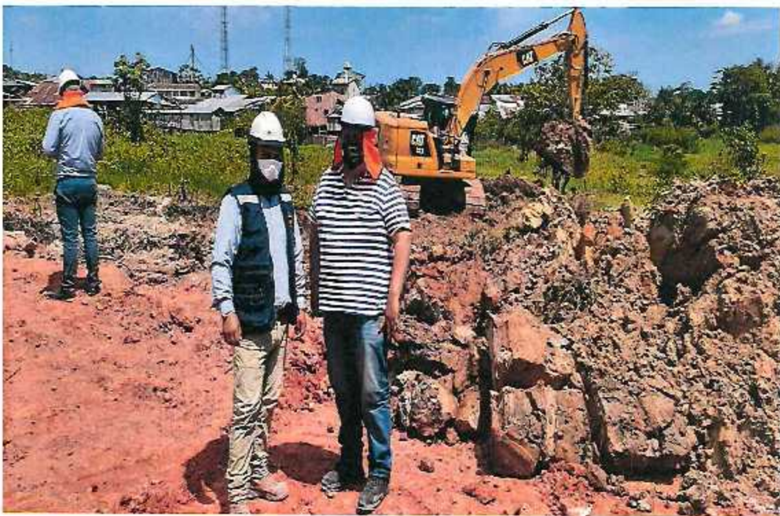
FOTOGRAFÍA N°12: TRABAJOS DE REMOCION DE MATERIAL EXCAVADO PREVIA ELIMINACION
