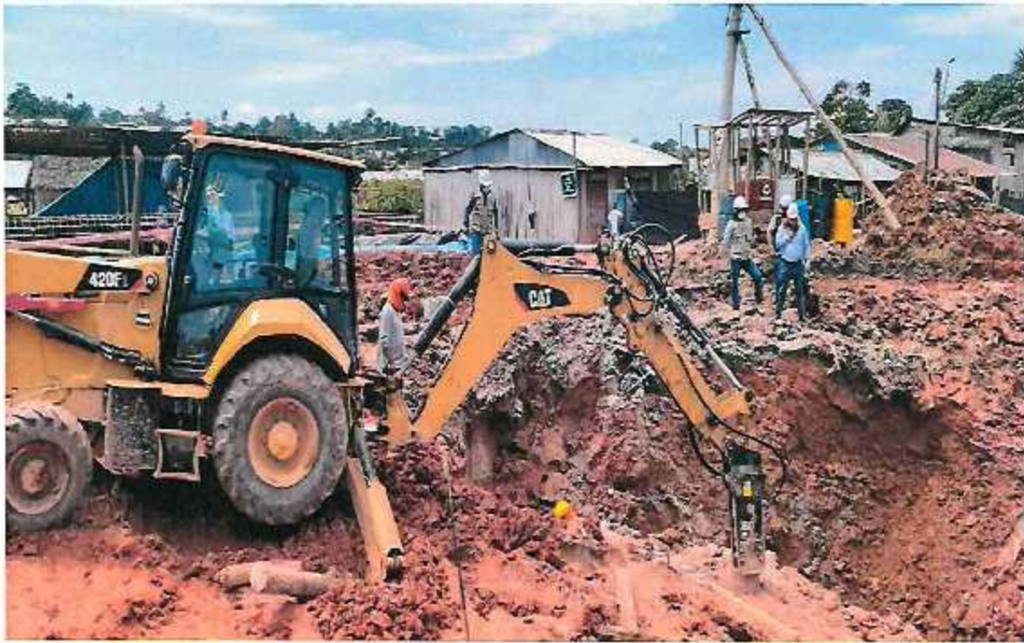
FOTOGRAFÍA N°07: TRABAJOS DE EXCAVACION CON MAQUINARIA PESADA
